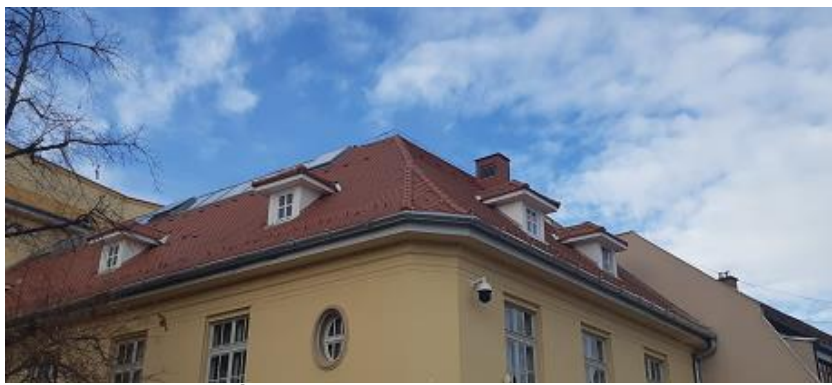
EGRI LENKEY JÁNOS ÁLTALÁNOS ISKOLA TETŐSZERKEZETE
