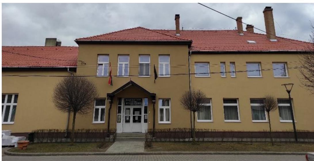
Az épület új tetőszerkezete
