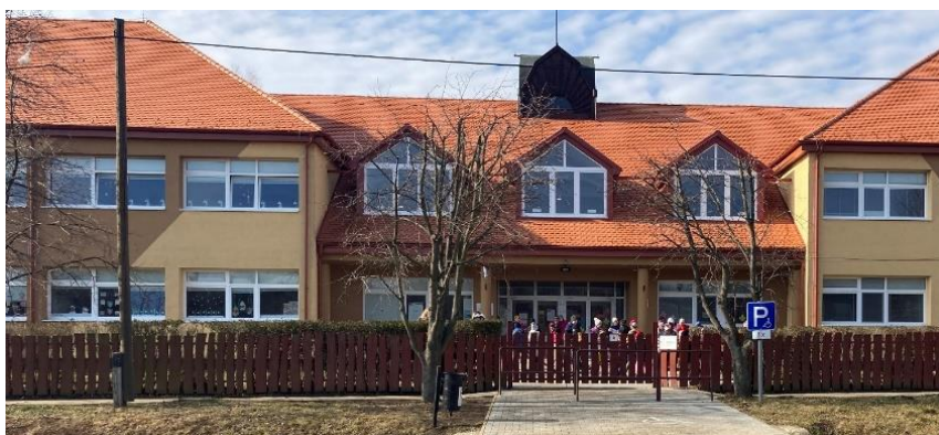
A Berceli Széchenyi István Általános Iskola homlokzata
