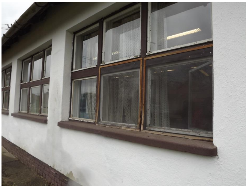
Csabacsüdi Trefort Ágoston Általános Iskola Iskola utca felőli nyílászáró
